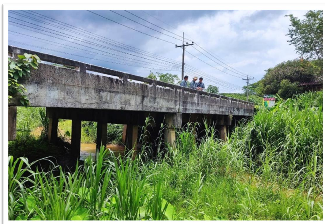
รูปที่ 4 - 11 สํารวจจุดติดตั้งสถานีสำรวจอุทกวิทยา น้ำแม่ตาช้าง บ้านใหม่เจริญ ต.ป่าแดด อ.แม่สรวย จ.เชียงราย (ท้ายโครงการอ่างเก็บน้ำแม่ตาช้าง จังหวัดเชียงราย)
